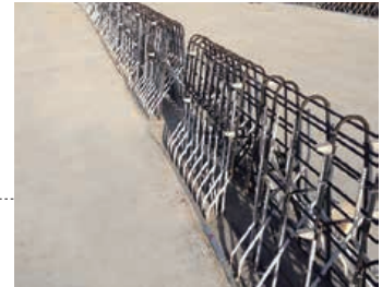
三遠南信道路 壁高寛 Vカット目地部補強筋
