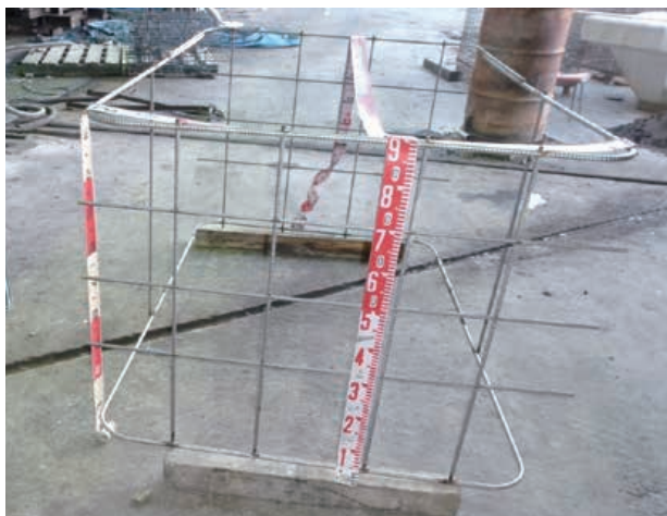
宮城県海岸 災害復旧工事 コンクリートボックス配筋
