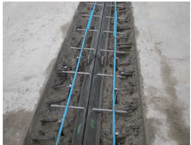
Keep dry Eの設置 (製造販売元:ネクスコ東日本エンジニアリング)
