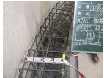
北鈴第二高区配水池 耐震補強のアンカー
