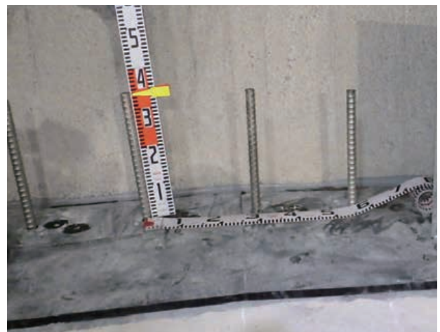
北鈴第二高区配水池 耐震補強のアンカー
