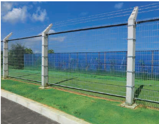
新石川浄水場フェンス コンクリート柱
