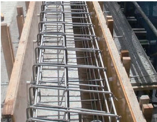
153号韮第一溝橋 地覆鉄筋
