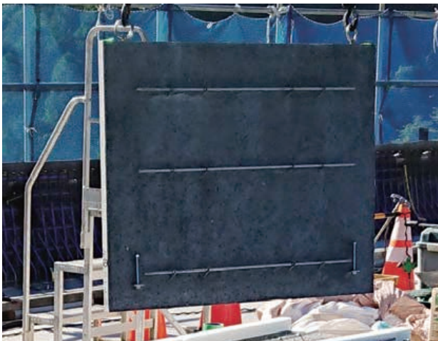
今戸高架橋 壁高欄埋設型枠配筋
