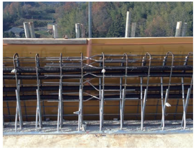
三遠南信道路 壁高寛 Vカット目地部補強筋
